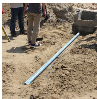
图10 混凝土浇筑式固定端现场埋设图
