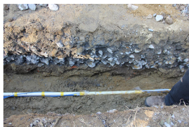
图8 钢管预制桩式固定端现场埋设图
